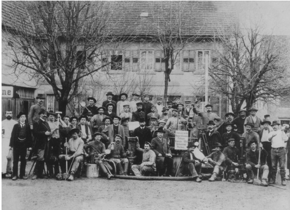
Wasserleitungsbau 1904 in Flehingen
